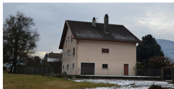
TOITURE 1 PENTE AU SUD - ENTREPRISE EXISTANTE
